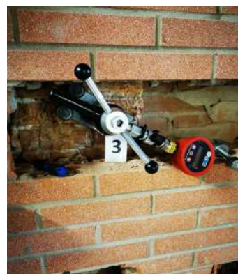
Prove in cantiere
