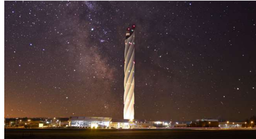
ThyssenKrupp Test Tower · Rottweil.
