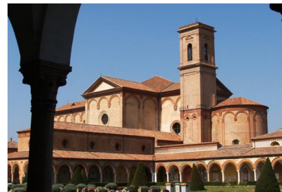
Progetto di restauro e miglioramento sismico Chiesa S. Cristoforo alla Certosa Restoration and seismic retrofit of the S. Cristoforo alla Certosa Church
