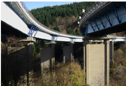
Adeguamento sismico ed a fatica di un viadotto lungo l'Autostrada A1 Milano-Roma-Napoli Seismic and fatigue retrofit of a viaduct along the A1 Milan-Rome-Naples highway
